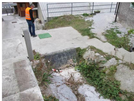
Sliki: Struga hudournika - pritok G in vtok v zamrežen prepust potoka
