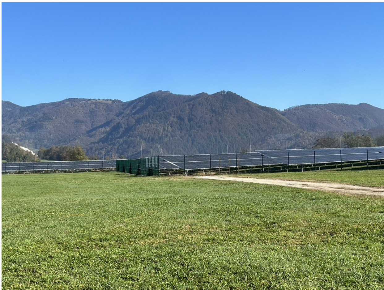
Slika 14: Prikaz obstoječe sončne elektrarne SEP1 (pogled iz območja predvidenega plana proti severovzhodu)
