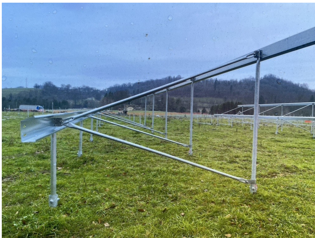
Slika 20: Prikaz postavitve nosilne konstrukcije za SEP1 (Vir: H-E - Energetska družba Trbovlje)
