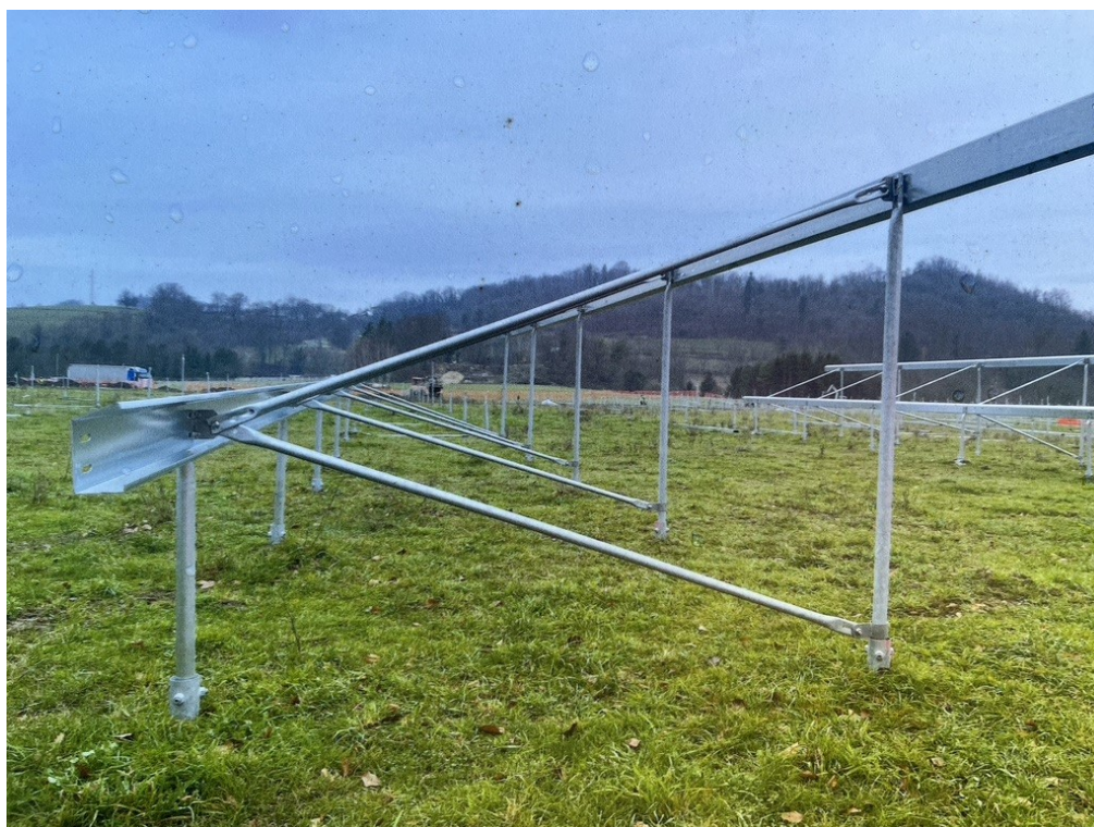
Slika 28: Prikaz postavitve nosilne konstrukcije za SEP1 (Vir: H-E - Energetska družba Trbovlje)
